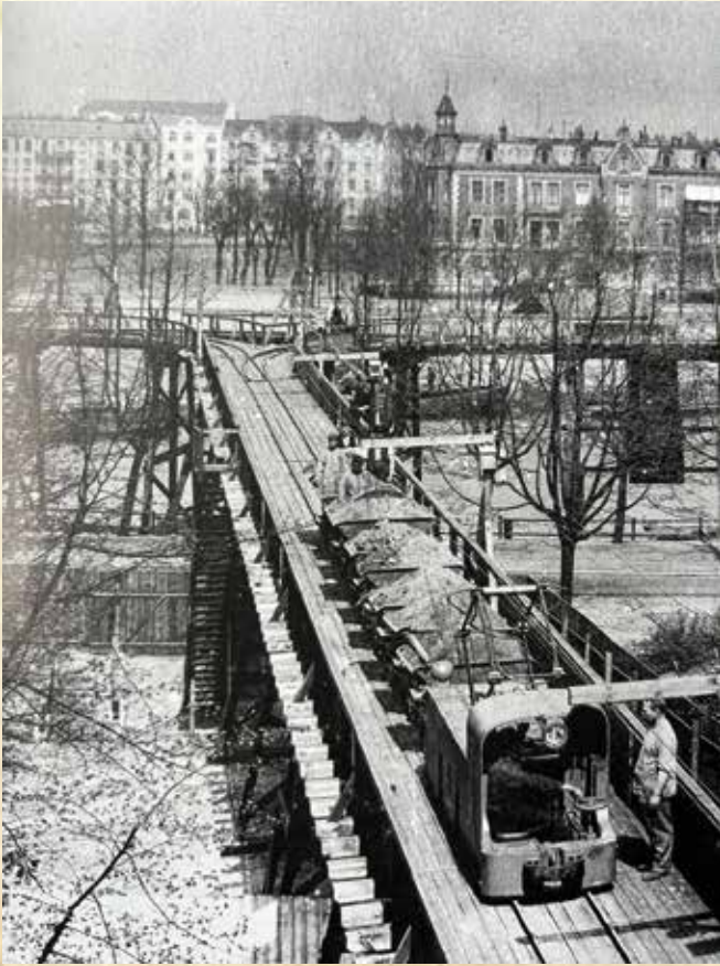
Abbildung 1: Bau der Ringlinie U3 nahe der Mundsburg. Hohenfelde und Uhlenhorst. Archivbilder. 2014, S. 12 f.
