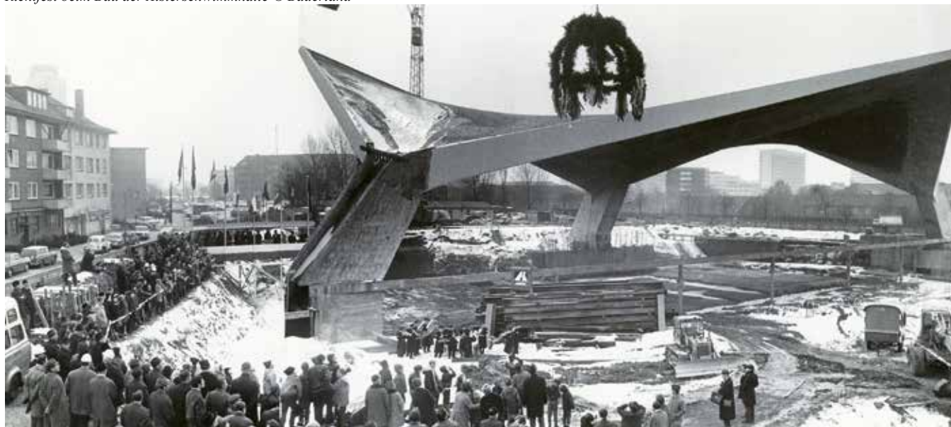
Richtfest beim Bau der Alsterschwimmhalle © Bäderland
