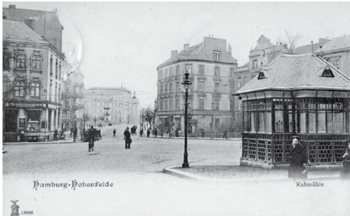
Blick in Richtung Kuhmühlenbrücke, 1916
